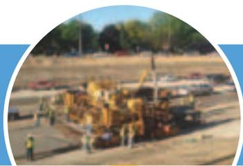
« Sans le système de guidage d'engins pour finisseurs de Trimble et l'élimination des cordeaux, ce chantier aurait nécessité 12 installateurs de cordeaux à plein temps juste pour délimiter la zone de rabotage. À présent, ces opérateurs peuvent se consacrer à d'autres tâches importantes. »
